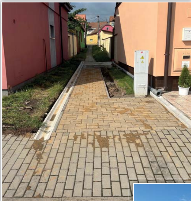
Oprava chodníku a odtoku dešťové vody v Nedakonických
