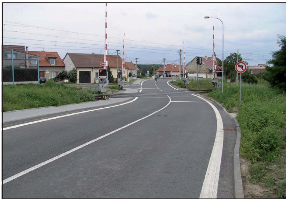
Silnice II/427 - železniční přejezd
