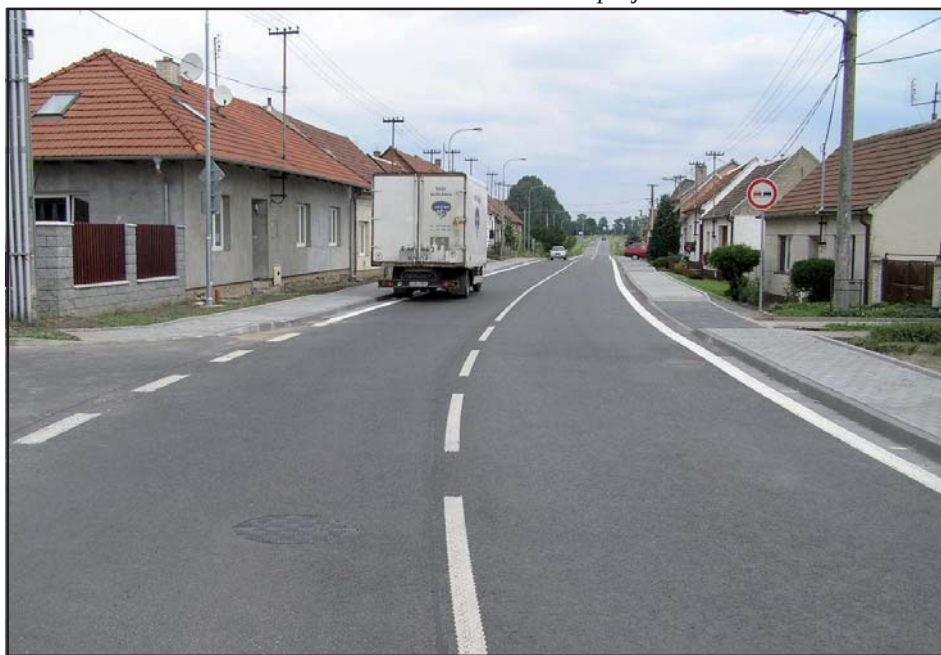
Silnice II/427 směr Polešovice
