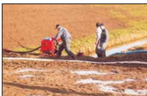
Čerpání vody z kanalizace u protipovodňové hráze Povodeň jaro 2005
