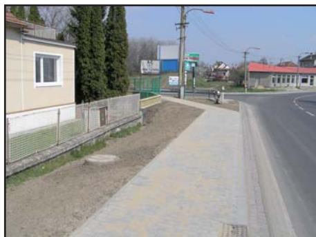
dokončení chodníku v kolonii
