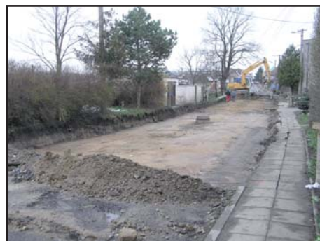
rekonstrukce silnice II./427
