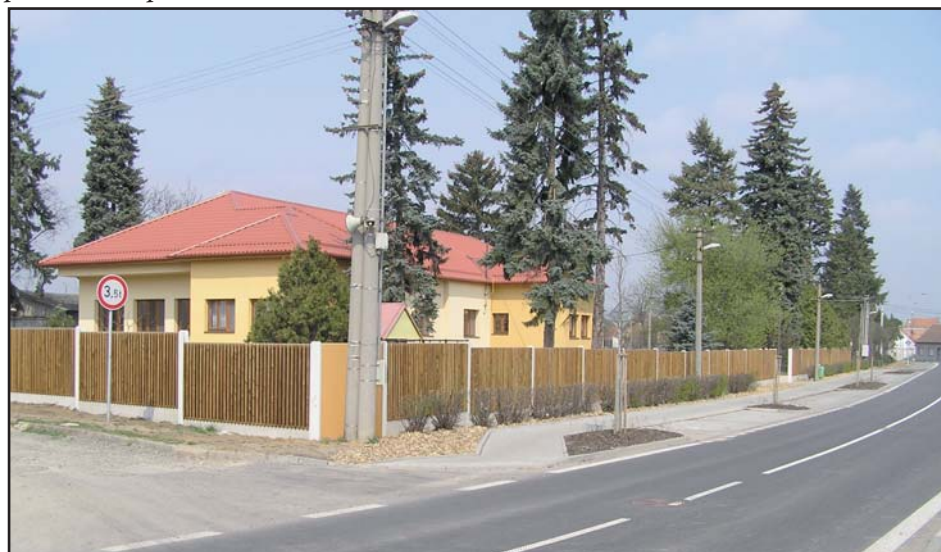
protihluková stěna u MŠ
