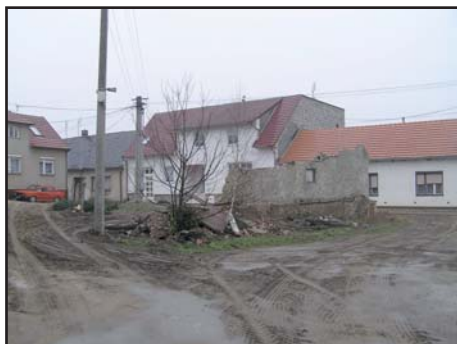
demolice obecního domu v ulici Hliník
